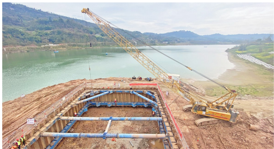
正在施工的金沙沱江特大桥
