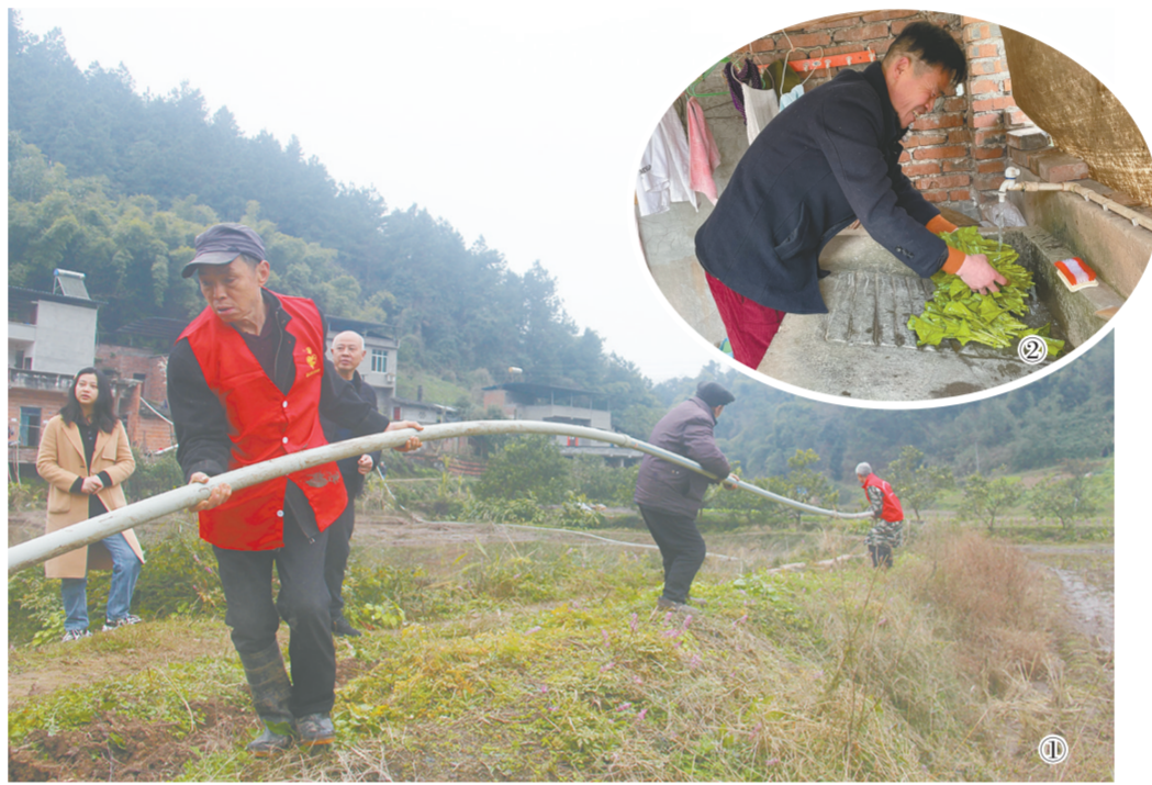
图①为志愿者正在搬运饮用水管道。
