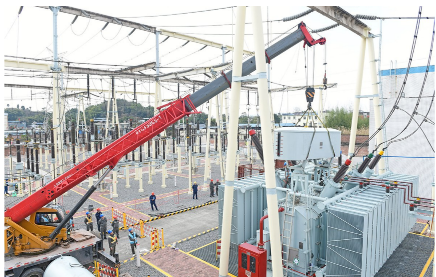
施工现场 合川供电公司供图
