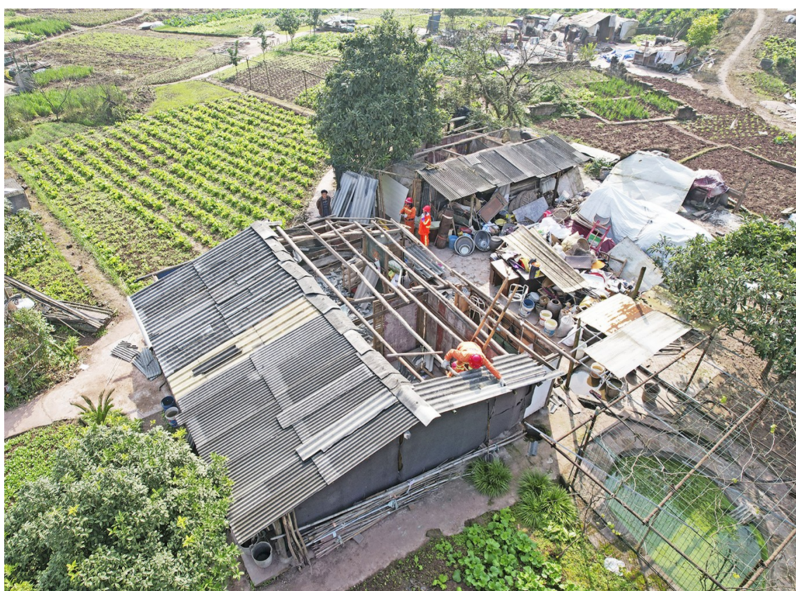
拆除违章建筑
