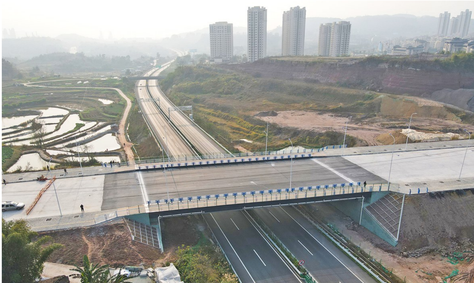
沙马路建成通车后,打通了沙溪片区交通干道。图为上跨三环高速桥。
