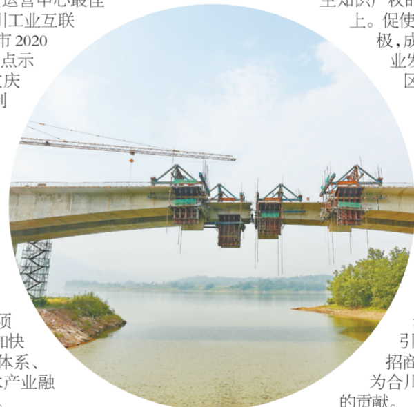
富裕溪大桥施工现场
